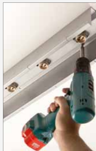
Collegamento elettrico e fissaggio della barra Electrical connection and bar fastening
