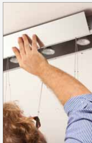
Posizionamento della fascia di rivestimento Cover assembly
