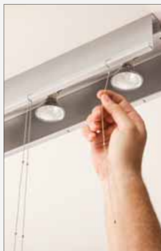
Inserimento dei cavi e loro taglio a misura Stainless steel cables insertion and cut
