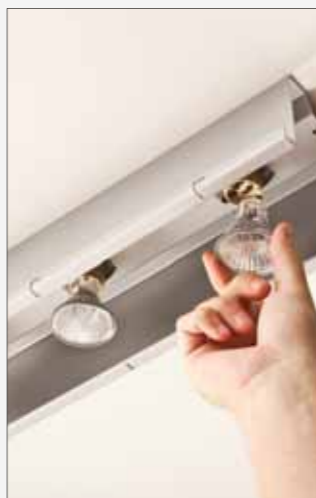
Inserimento delle lampadine Light bulbs installation
