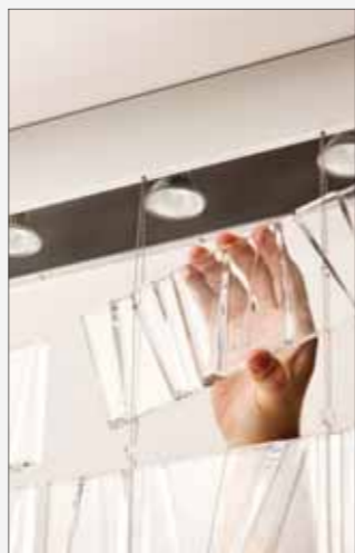
Inserimento degli elementi in vetro Glass tiles insertion
