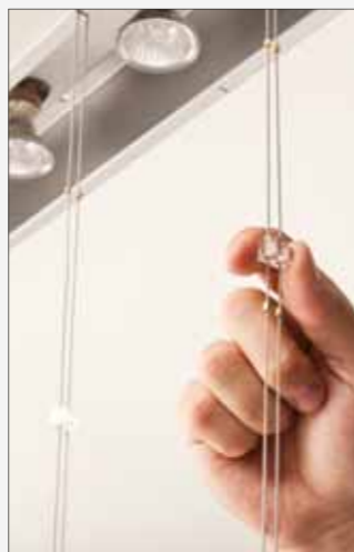
Montaggio dei ferma vetro Glass fastener assembly
